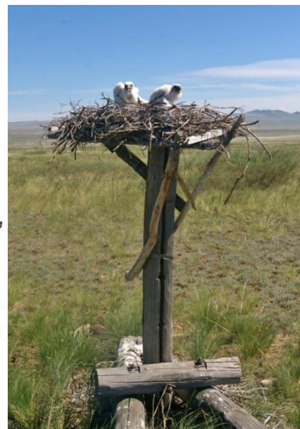
Рисунок 6-7. Устройство столбов с гнездовыми платформами или присадами: а) на железобетонной или металлической опоре (труба), б) на деревянной опоре
